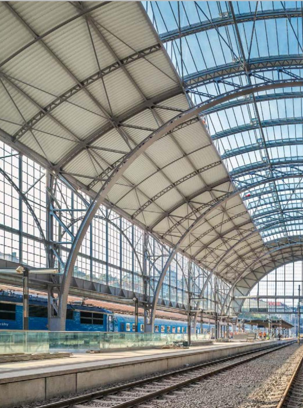
← Den Bestandteil unserer Lieferung bildet die Überholung und Austausch von Fassadenpaneelen einschließlich der Glasfüllungen, Austausch von Glasfüllungen der Lichtschächte, Ergänzung von Montageöffnungen für Beleuchtung, Kamerasystem und neue Klempnerelemente in dem Lichtschacht. Die Erneuerung der Überdachung wird während des Betriebs durchgeführt, der nur minimal reduziert wird.
