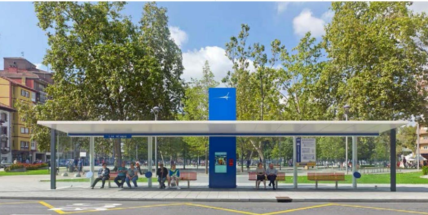
↑ Die zur Entwässerung verwendete Rinne geht aus der Hauptsäule heraus und wird in der ganzen Dachlänge installiert. Die Ableitungen befinden sich in den Säulen der Stahlkonstruktion.
