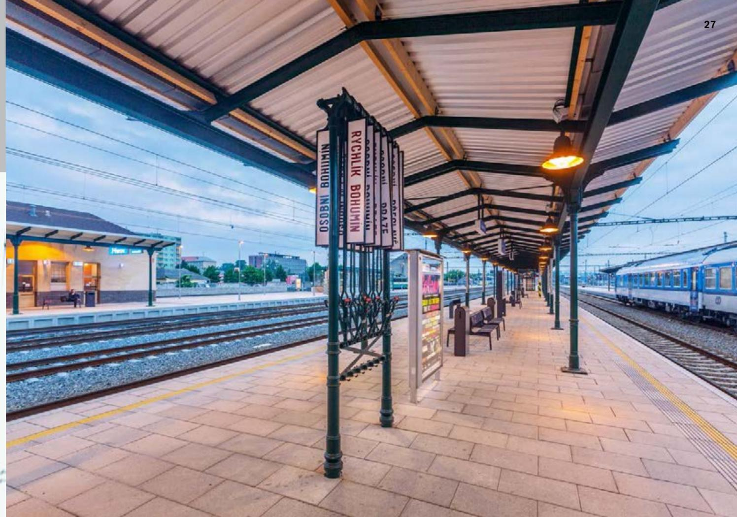
↑ Die Bahnsteige Nr. 1, 2 und 3 wurden überholt und in der ursprünglichen Länge von 140 m eingesetzt. Zum Inselbahnsteig Nr. 4 wurde ein leichtes Glasdach mit Stahlträgern geplant. Die gleiche Konstruktion wurde auch für den Ausbau von oberirdischen Teilen der Aufzugsschächte verwendet.
