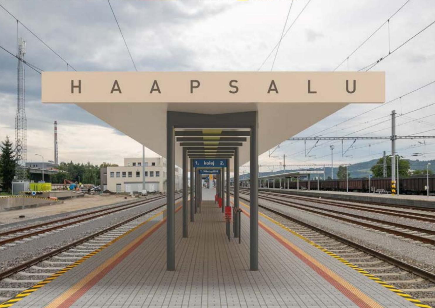
↓ Die zweischalige Dachhaut besteht aus einem PUR- Sandwichpaneel mit Sicherheitsglas, das eine falsche Untersicht bildet. Auf dem Dach kann man eine Verglasung mit einer Farbgraphik gestalten.
