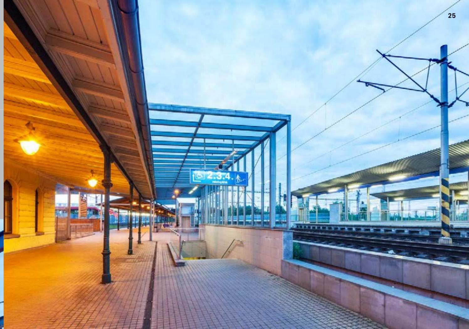
↑ Die historischen Guß- und Stahlkonstruktion wurden fachgemäß restauriert, mit geeignetem Korrosionsschutz versehen und wieder in die ursprünglichen Positionen versetzt. Die beschädigten Säulen wurden abgeformt und durch Repliken ersetzt. Alle neu durchgeführten Zimmerer- und Tischlerkonstruktionen wurden komplett nach den zeitgemäßen Parametern – mit vollem Einschub und zweifachem Standfalz – hergestellt.
