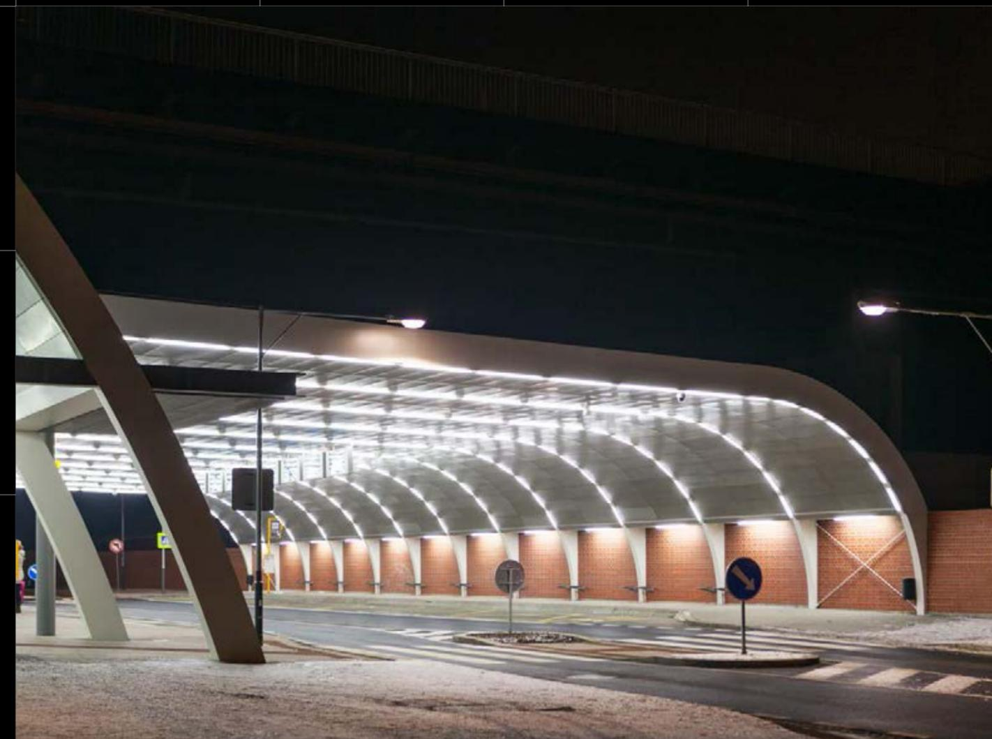
Bei technischen Lösungen berücksichtigen wir immer auch ihre visuelle Wirkung. Die Objekte des Umsteigerterminals Ostrava-Svinov wurden als eine leichte Stahlkonstruktion mit Strukturverglasung aus Einscheibensicherheitsglas realisiert. Die subtilen Dachhäute der Objekte, überdeckt durch Sichtattika, werden mit den Sandwich-Paneeelen versehen, wo den Aussenmantel zwecks bedingten Stahls Rundbläche bilden.
