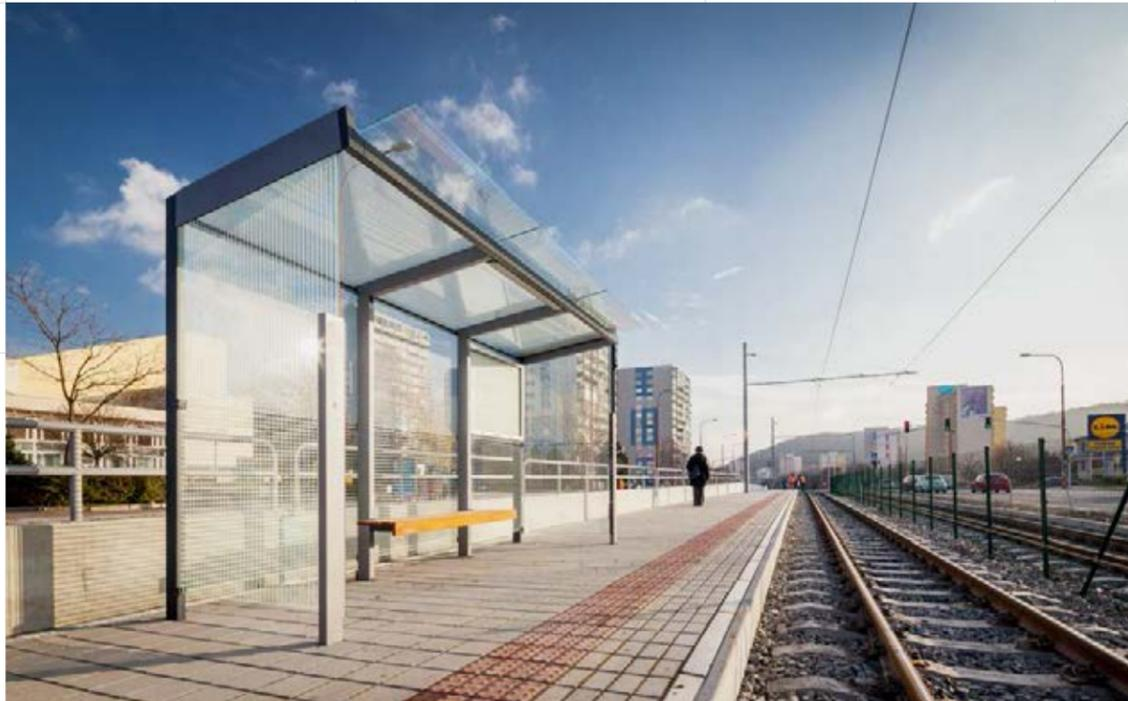
↑ Die Dachverglasung befindet sich zwischen den Seitenträgern und wird vom vorgesetzten Profil unterstützt. Dieses Detail bildet einen visuellen Charakter vom ganzen Bauwerk. Die Verglasung der Seitenwände ist rahmenlos und von einem Schutzprofil gestützt. Die in den Raum tretende Kante ist teilweise vom Profil geschützt, von dem das Glas hinausgetragen wird.
