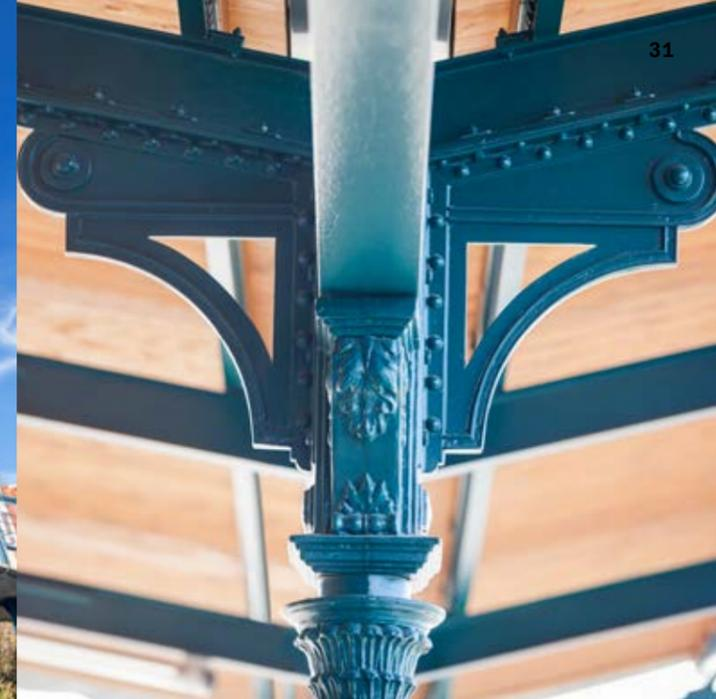
↖ Die Konstruktion der Überdachungen von Bahnsteigen ist nach den zeitgemäßen Produktions- und Baustandards hergestellt: aus verzieren mit Versteifungen miteinander verbundenen Gußsäulen und warmgewalzten Profilen mit dem sichtbaren Einschub der Dachhaut wie bei der diagonalen Halle.
