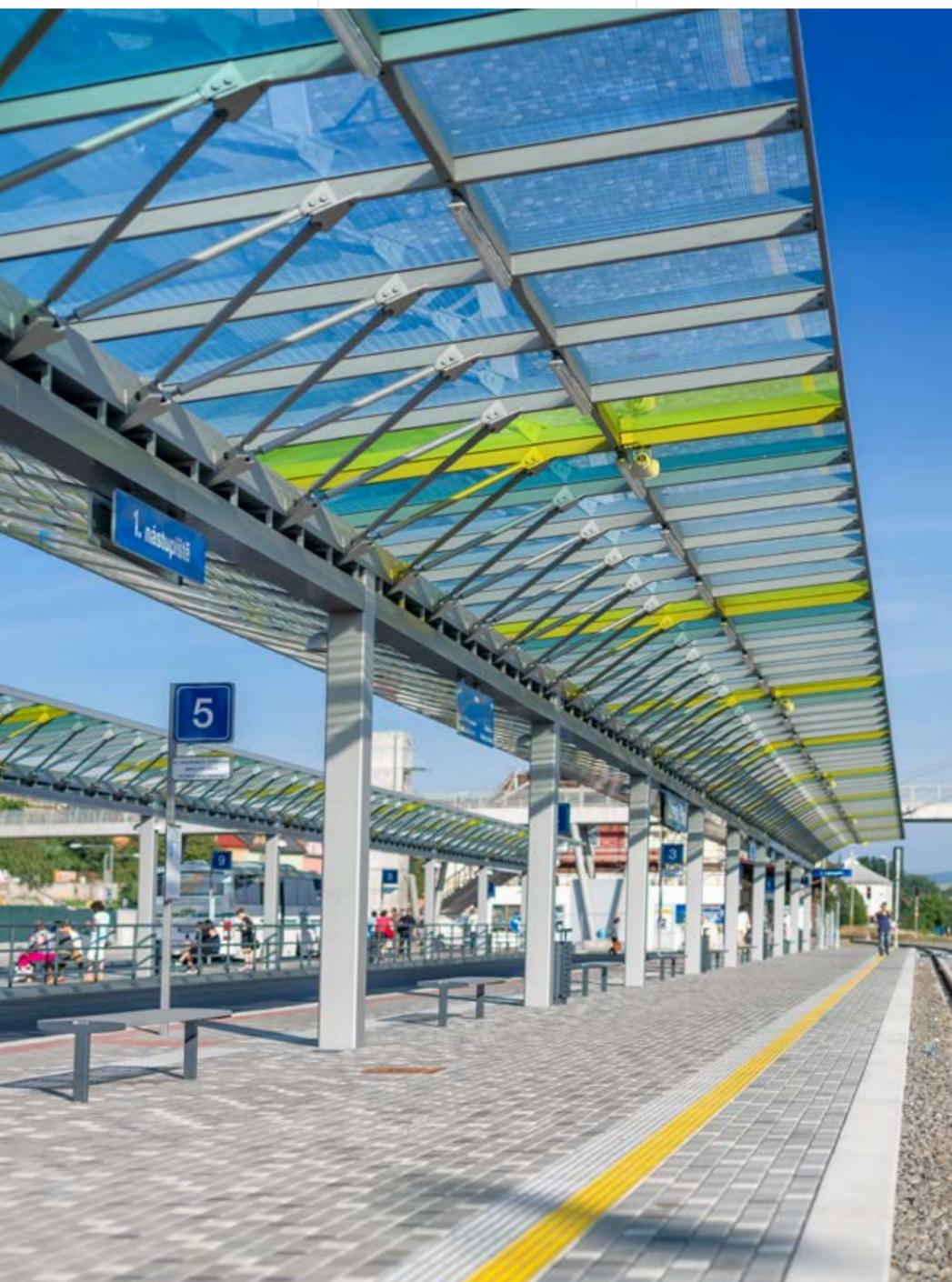
↑ Die Dachkonstruktion ist in einer Hälfte mit Verbund-sicherheitsglas ausgefüllt, die andere Hälfte ist voll und dient als Beschattungsfläche. Eine der Varianten stellt die Verwendung von kompletter Dachhaut aus Glas vor, wobei ein Teil untergehängt bleibt und der andere in die Glasprofile von oben eingesetzt wird. Als Beschattungselement kann man in diesem Fall einen graphischen Druck auf Glas oder eine Farbfolie verwenden.
