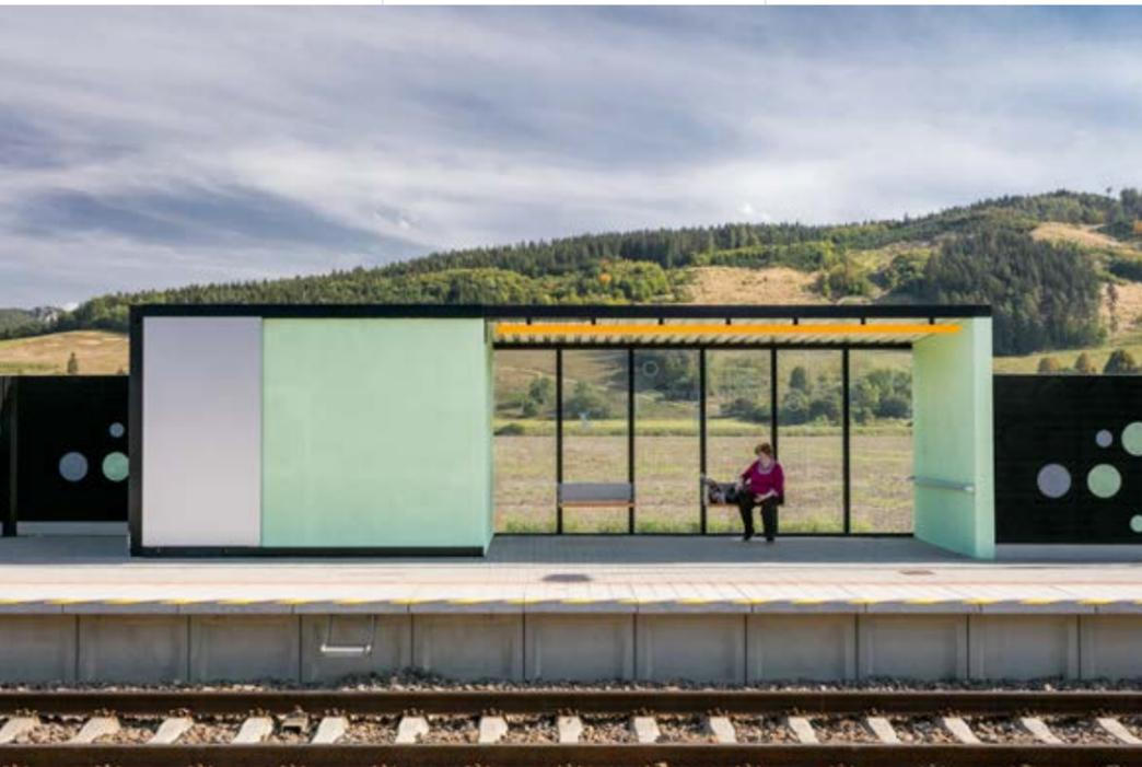
↘ Im Vorderteil ist ein markantes Linearlicht installiert, das genügend Beleuchtung für den Innenraum der Überdachung anbietet und mit seiner Farbigkeit das Dekor von umliegenden Lärmschutzwänden ergänzt.
