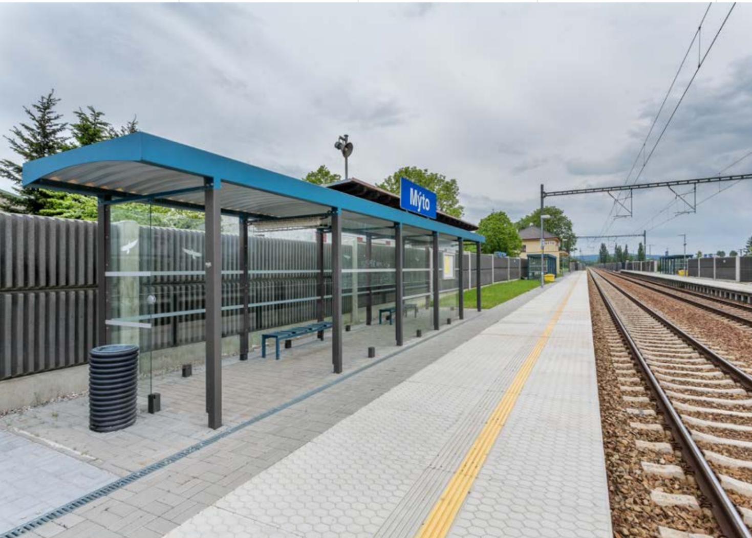
→ Einfache Sitzbänke kann man aus Stahl oder einer kompakten HPL Platte hergestellt. Die Hinterwand der Überdachung dient als eine natürliche Rücklehne.
