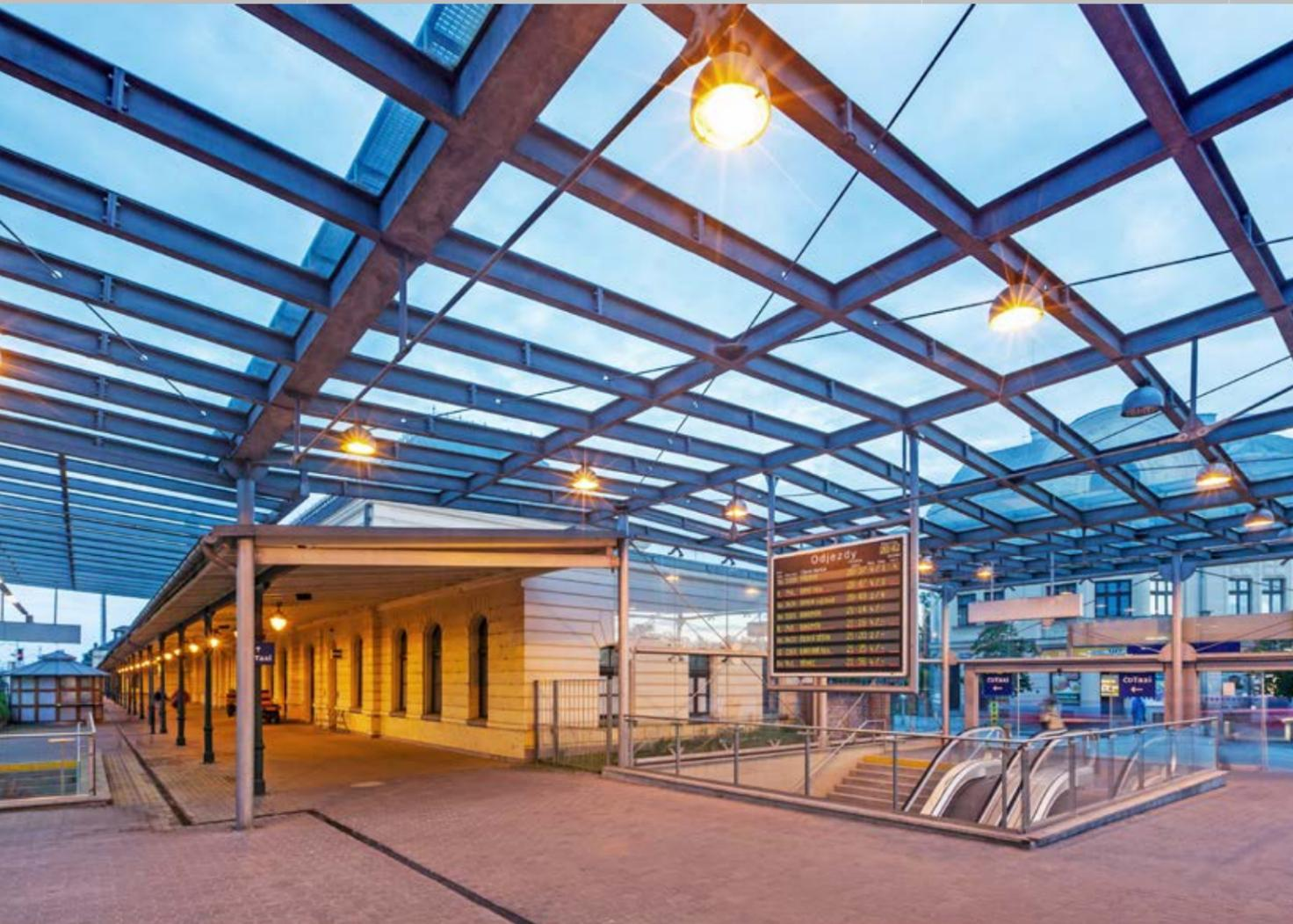
↑ Das Dach des sog. Opava Bahnsteigs hat eine Sattelform. Die Tragkonstruktion bilden zwei Reihen der Gußsäulen, die mittels Stahlpfetten verbunden sind und gegenseitig durch Spannversteifungen als Windverbände gesichert.
