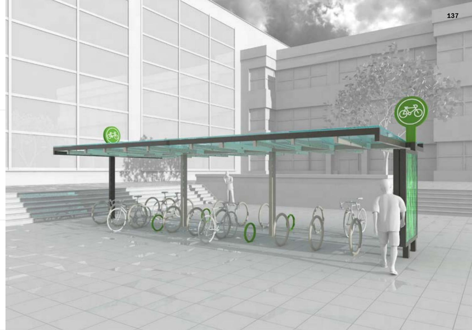
↑ Die Säule ist als ein beidseitiger Dachträger geschaffen und genau diese Variabilität ermöglicht einen radialen für eine größere Anzahl von Fahrrädern bestimmten Grundriss zu entwerfen. Es können aber auch zwei Überdachungen gegeneinander nach der Richtung der Straßenkommunikation installiert werden.
